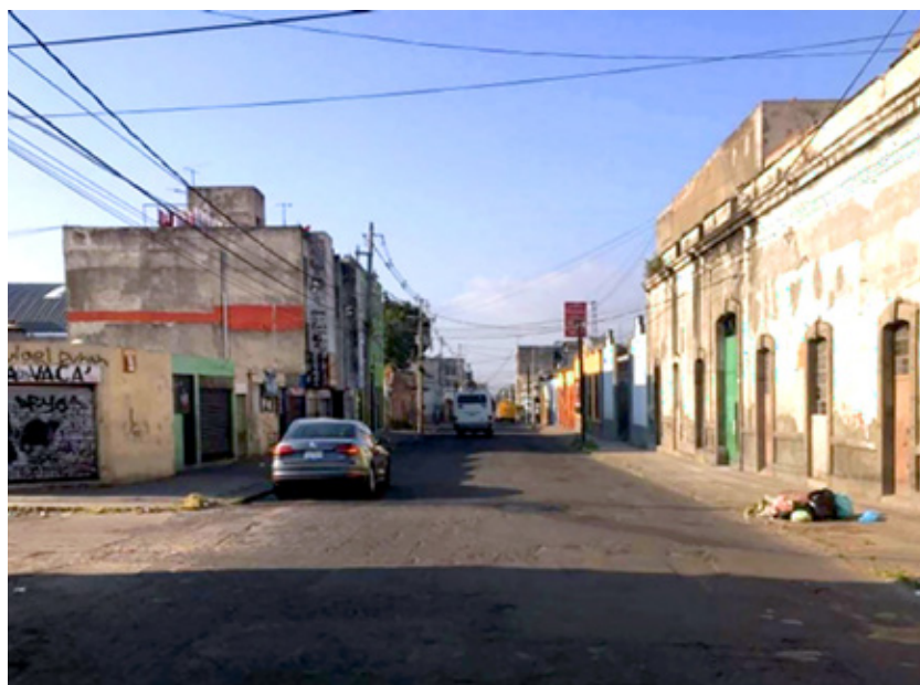
FIGURA 18. VISTA DE LA CALLE 7 NORTE DESDE LA 24 ORIENTE EN EL BARRIO DE EL REFUGIO (A LA DERECHA ESTÁ LA VECINDAD DE EL POCITO)
