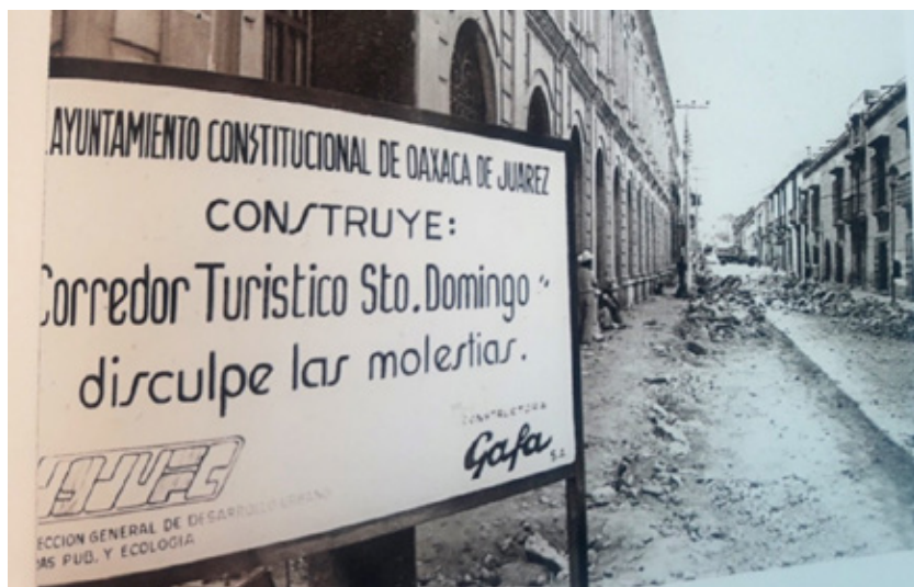
FIGURA 8. 1980, INICIO DE LA OBRA PARA HACER LA CALLE PEATONAL
